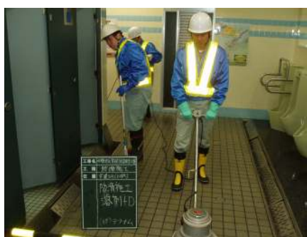
高速道路サービスエリア トイレ
